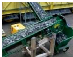
写真5：落下防止対策
